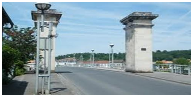
Port Ste Foy pont Montaigne
